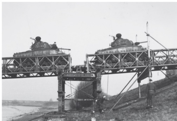
▼ Proefneming door 112 Pontoniersbataljon met een baileybrug op pontons. Sherman tanks nemen de brug. Moerdijk, december 1953
