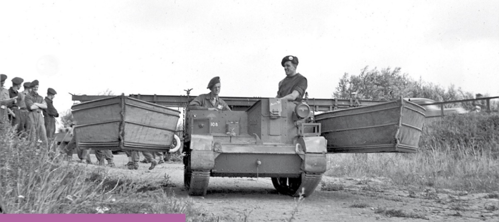
▲ Universal carrier van het Garderegiment Grenadiers waaraan d.m.v. een brugdeel twee opvouwbare boten zijn bevestigd. 1947-1949.
