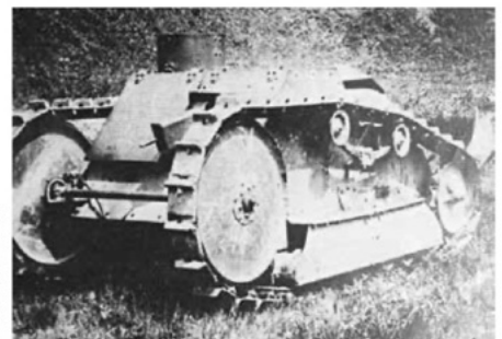
Waarschijnlijk het prototype van de Ford tank. Let op het trommelvormige torentje voor de bestuurder.
